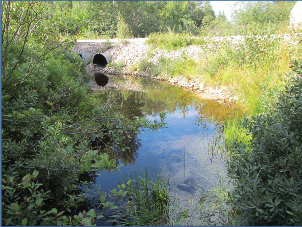
Photo 3 – Ruisseau R01 : Segment PE03
